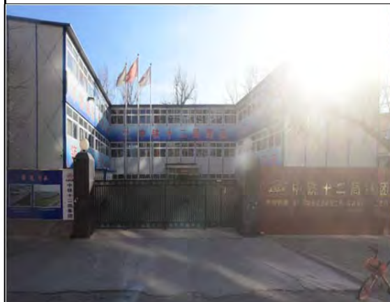
19.地块南侧在建京西大悦城
