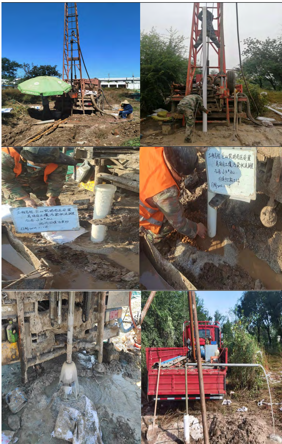
图 4.4-4 地下水监测井施工照片
