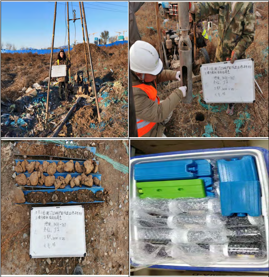
图 4.4-2 土壤采样现场照片
