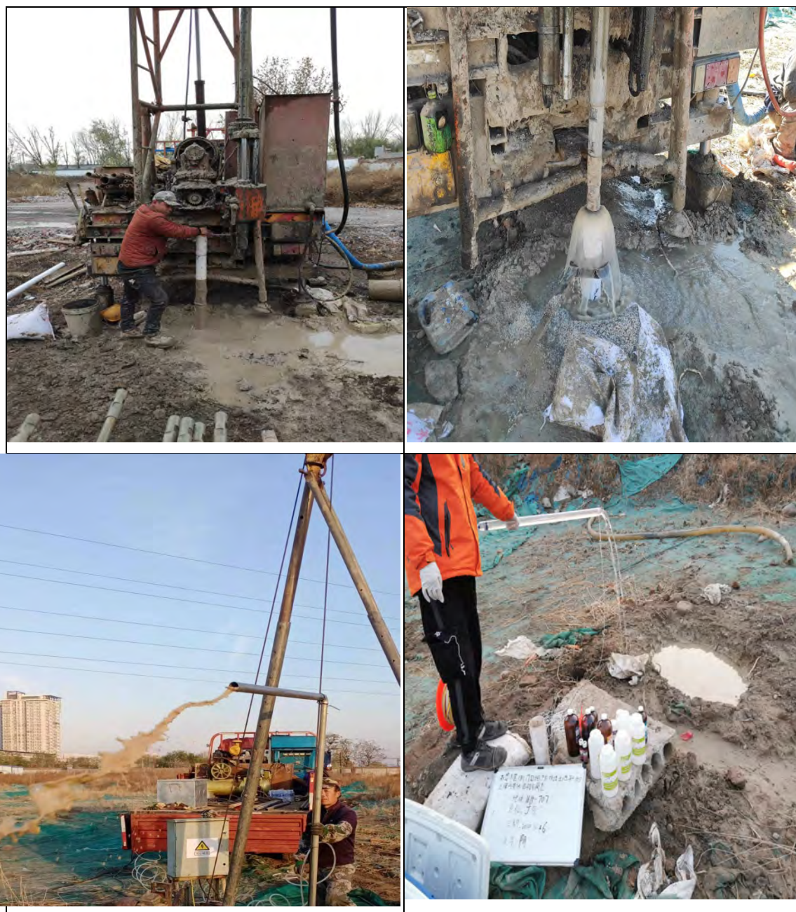
图 4.4-3 地下水监测井施工照片
